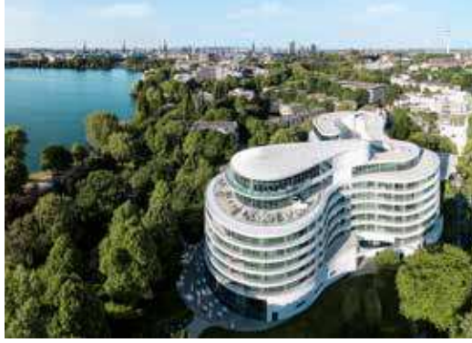
Foto: The Fontenay
