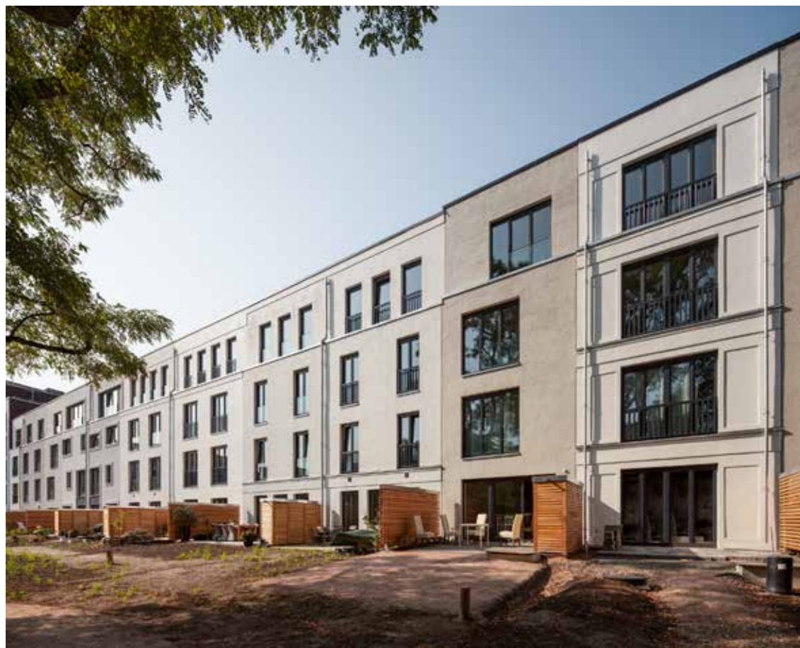
Die 22 Häuser wurden als ein Mehrfamilienhaus mit verschiedenen Fassadenteilen gebaut, hier die Gartenseite
