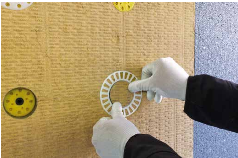
Der Tellerdübel mit Zusatz-Versenkteller wird oberflächennah versenkt und mit einer Mineralwoll-Rondelle bündig zur Oberfläche abgedeckt
