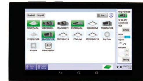
Die Anbindung an Cloud Services ermöglicht eine ortsunabhängige Regelung einer oder mehrerer Standorte
