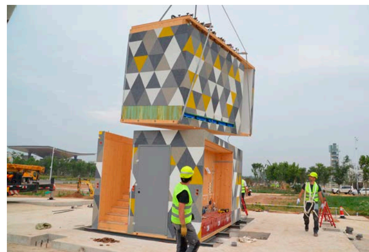
Anschlussfertig ausgestattet wurde der „Core“ auf die Baustelle geliefert
