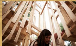
Die Treppe stabilisiert die Konstruktion zusätzlich
