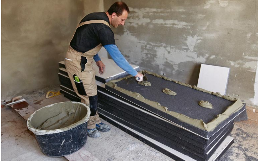
Das Ankleben der Platten erfolgte im Punkt-Wulst-Verfahren, das durch eine umlaufende Wulst an den Plattenrändern Konvektion und dadurch bedingte Feuchteschäden bzw. Schimmelbildung verhindert
