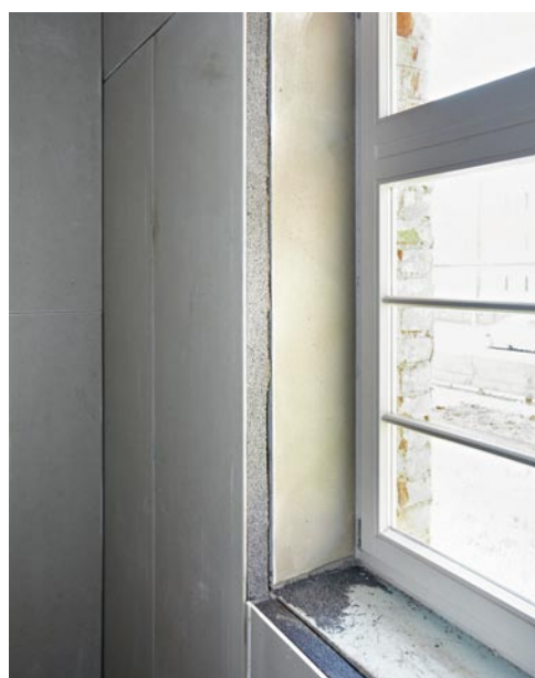
Das Ankleben der Platten erfolgte im Punkt-Wulst-Verfahren, das durch eine umlaufende Wulst an den Plattenrändern Konvektion und dadurch bedingte Feuchteschäden bzw. Schimmelbildung verhindert
