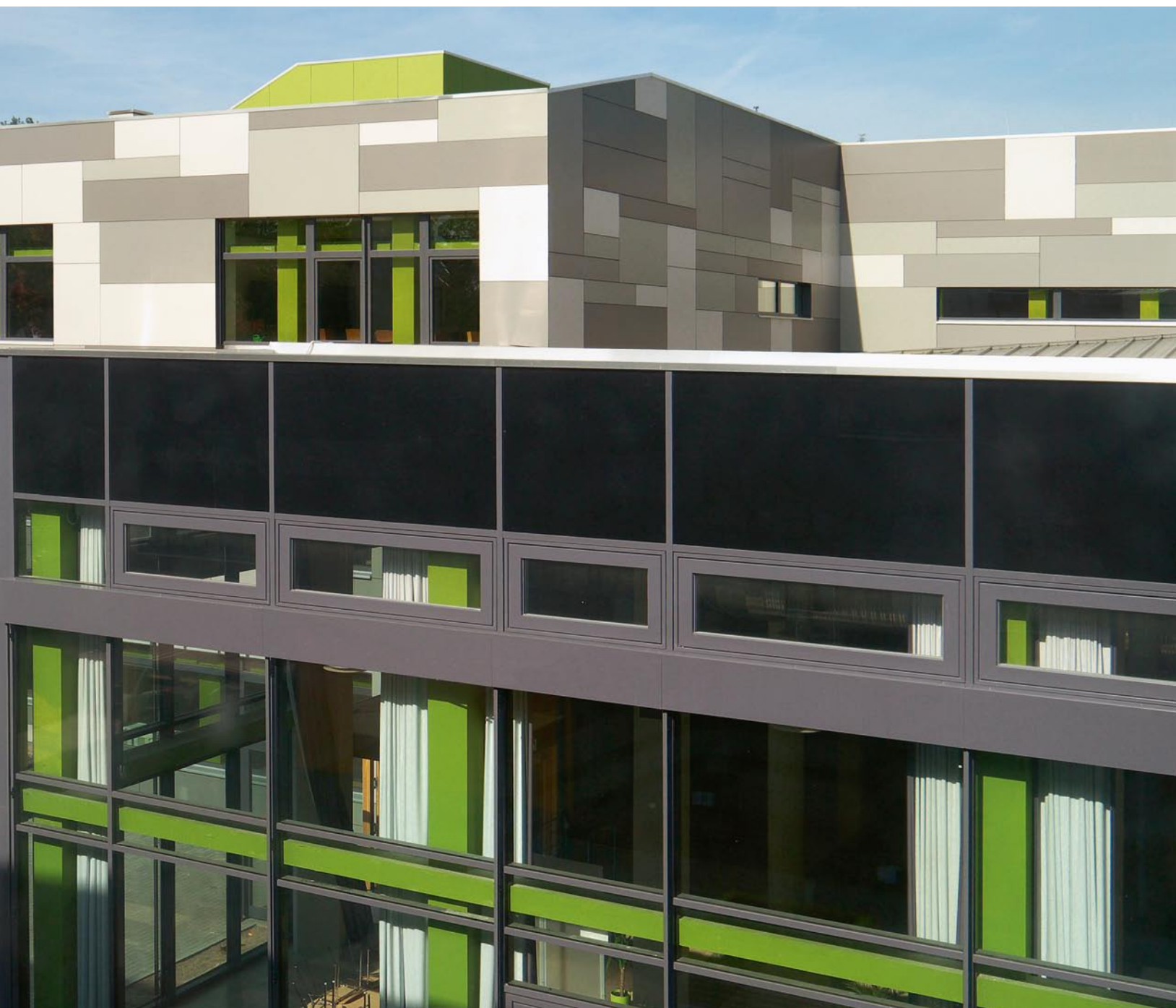
Die thermische Hülle „hängt“ jetzt vor der Tragkonstruktion. Durch die neuen Fenster hindurch ist die Skelettbauweise von außen zu erkennen
