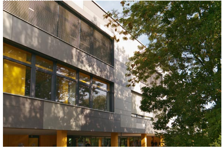
Durch ein automatisch geregeltes Öffnen der Fenster bzw. durch die geothermisch vorgekühlte Zuluft wird die Gebäudemasse nachts abgekühlt und steht am folgenden Tag wieder als Speichermasse zur Verfügung
