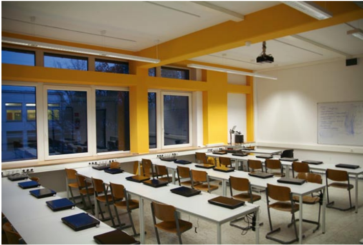
Im Sommer wird die Schule „passiv“ gekühlt. Der Sonnenschutz verhindert ein Überhitzen der Räume. Die Gebäudemasse nimmt tagsüber die entstehende Wärme auf
