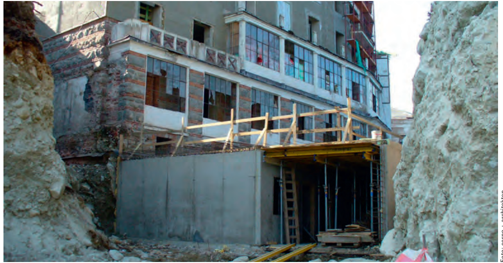
Das neue Untergeschoss mit dem Wellnessbereich schiebt sich unter das vorhandene Gebäude. Da die alte Gründung nur aus 1,20m Steinen bestand, wurde das komplette Gebäude aufwendig unterfangen
