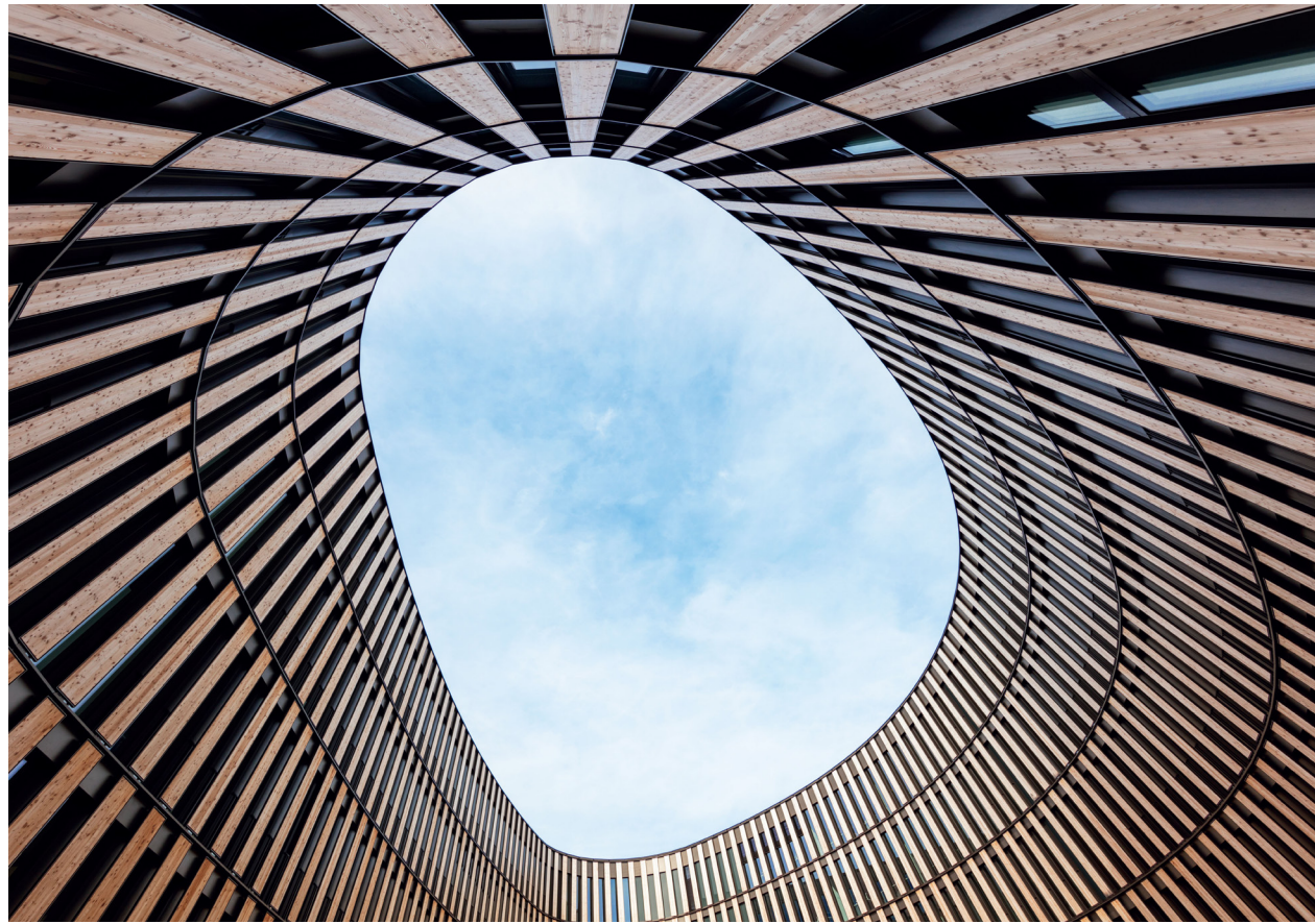
Im Innenhof wurde die Fassadengestaltung optisch angeglichen
