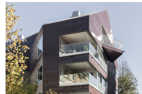
Wohnhaus Solaris, Zürich/CH – Architekten huggenbergerfries | Module ertex solar
