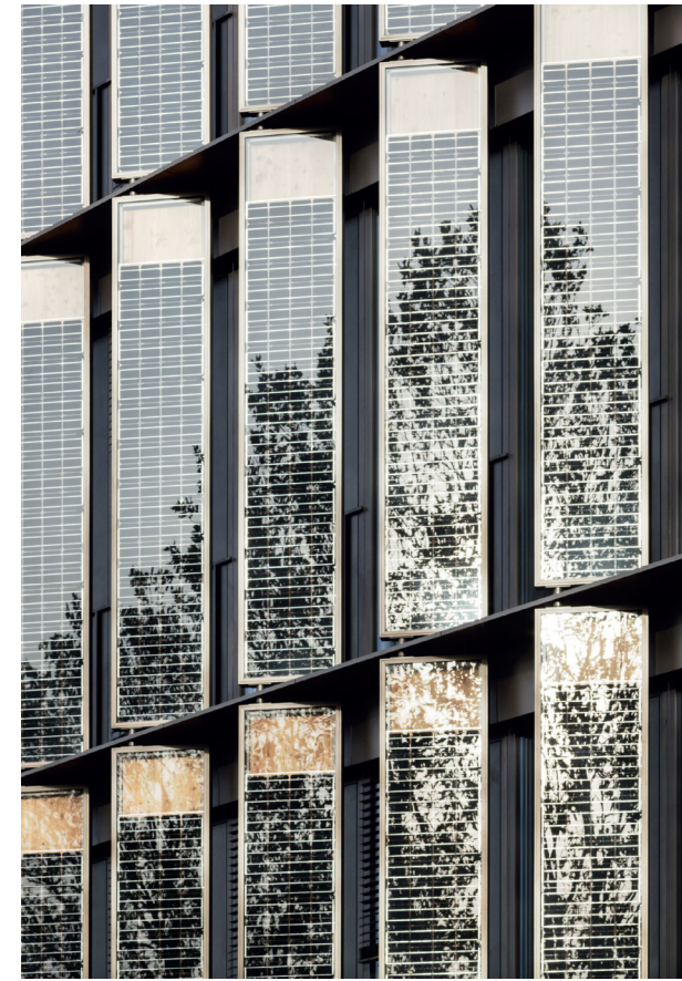
Die Aluminium-Pfosten-Riegel-Fassade mit ihren für die natürliche Lüftung nach außen gefalteten Photovoltaik-Elementen wurde von ingenhoven architects entworfen
