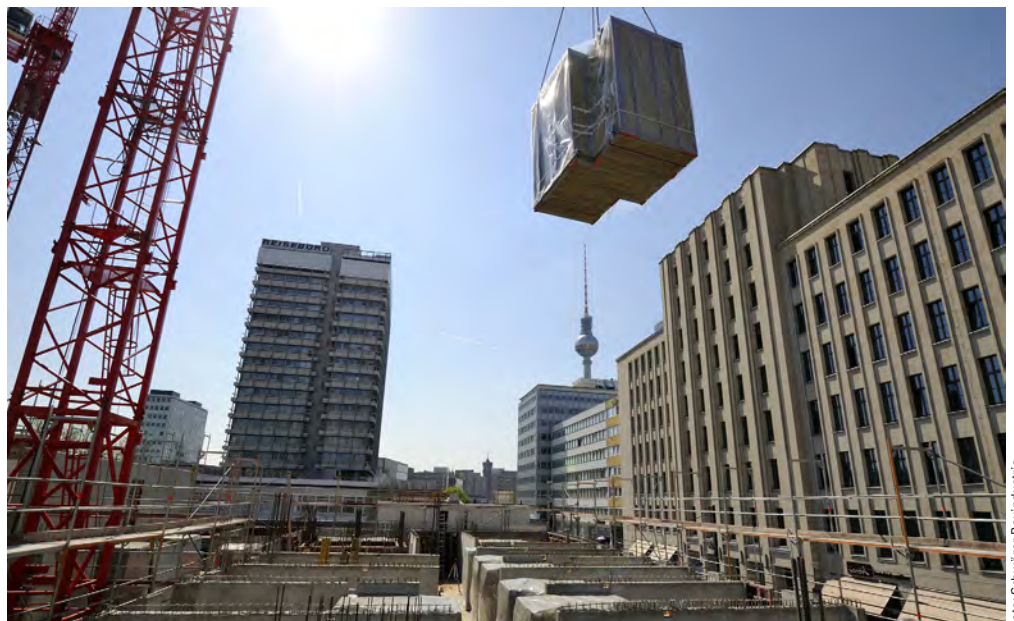
Montage: Über einen Kran werden die fertigen Bäder in das Gebäude – hier das Alexander Parkside – gehoben
