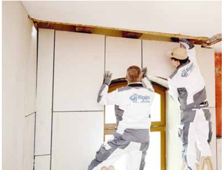
Die Innendämmplatten werden später oberflächenfertig verspachtelt
