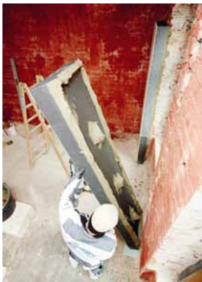
Ankleben mit Punkt-Wulst-Verfahren
