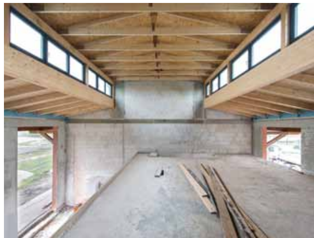
Wohnungstrennwände und neues Dach
