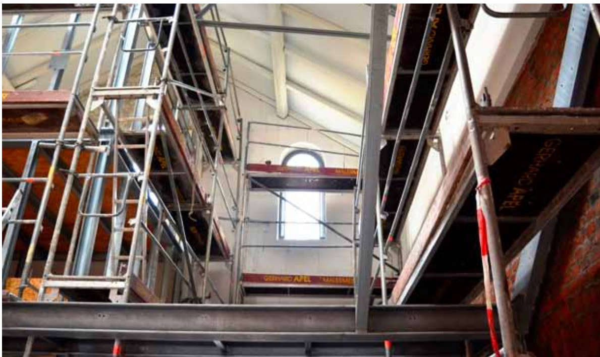
Bis in die Giebelspitze kamen bei der Sanierung Innendämm-Systeme zum Einsatz
