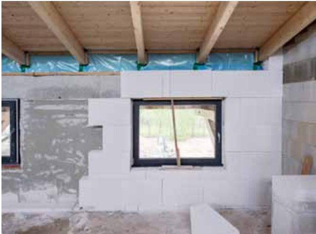
Nach der Reinigung des Bestandsmauerwerks und dem Auftrag eines Ausgleichputzes wurden die Dämmplatten verlegt
