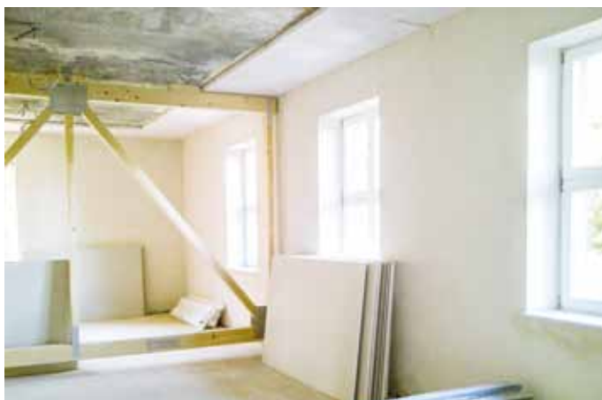
Verarbeitet wurden Mineralschaum-Dämmplatten mit hoher Diffusionsoffenheit
