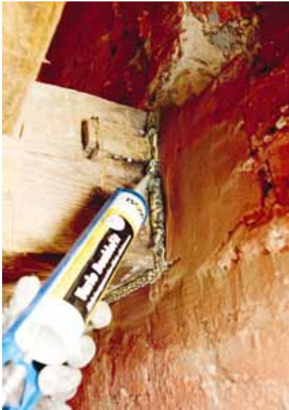
Luftdichter Anschluss ans Mauerwerk
