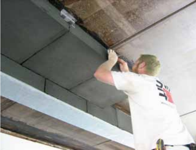
Dämmung von Unterzügen und Decken mit nichtbrennbaren Schaumglas-Dämmplatten
