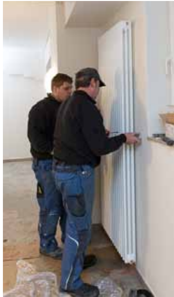
links: Heizkörper werden mit Spezialdübeln befestigt
