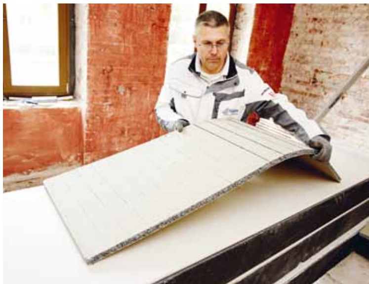
Die ThermoPlatte wurde eingeritzt und für die Laibungen zurechtgebogen
