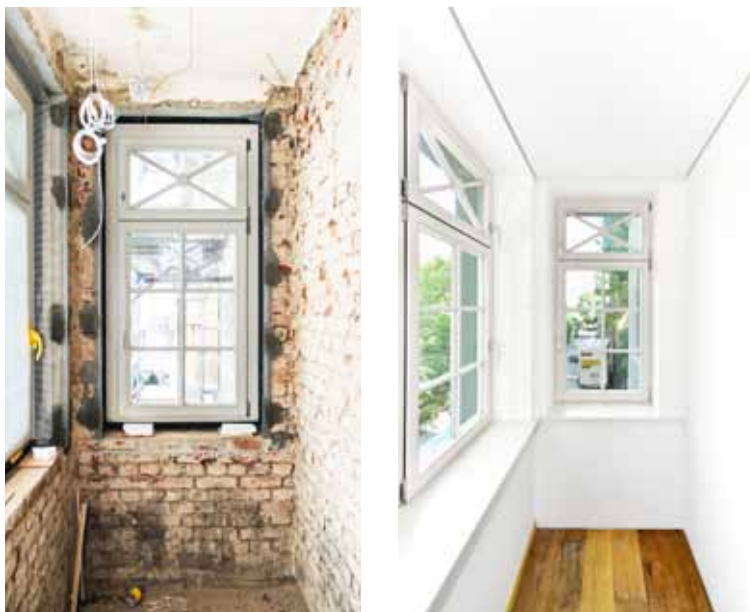
Abschließend wurde ein mineralischer Feinputz auf Kalkbasis aufgetragen
