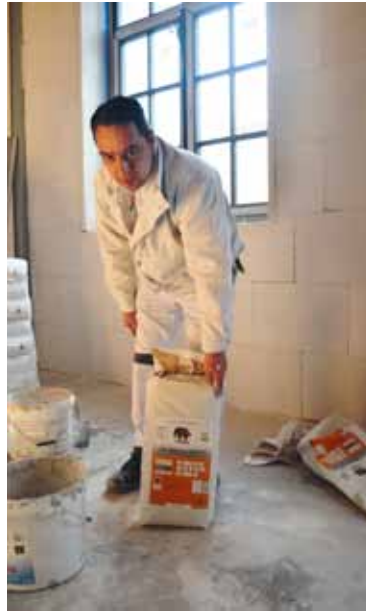
Der IDS Meistermörtel verbindet Mauerwerk und Dämmplatten und dient zur Armierung und Oberflächenbeschichtung
